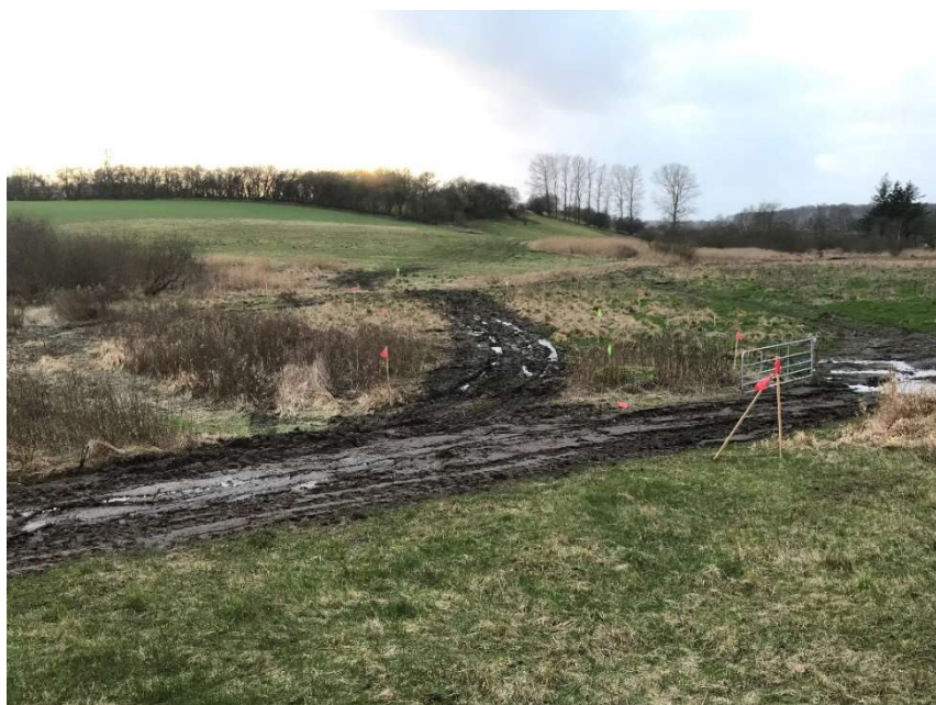
Foto: 17.02.2020 Digeområdet set fra nord. De røde flag er hvor diget rammer nuværende terræn. De grønne flag er toppen af diget afmålt til rigtig kote. Kørespor er fra ny hegnsetablering til græsning af naturområderne.
