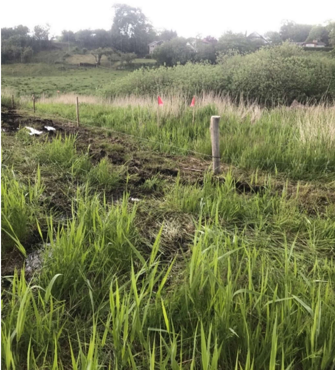
Foto 06.06.2020 foto af sydligste del af digestart (røde flag) set mod nord. Diget vil gå i en buet linie udenom mosens pilekrat på det mere tørre areal T1.
